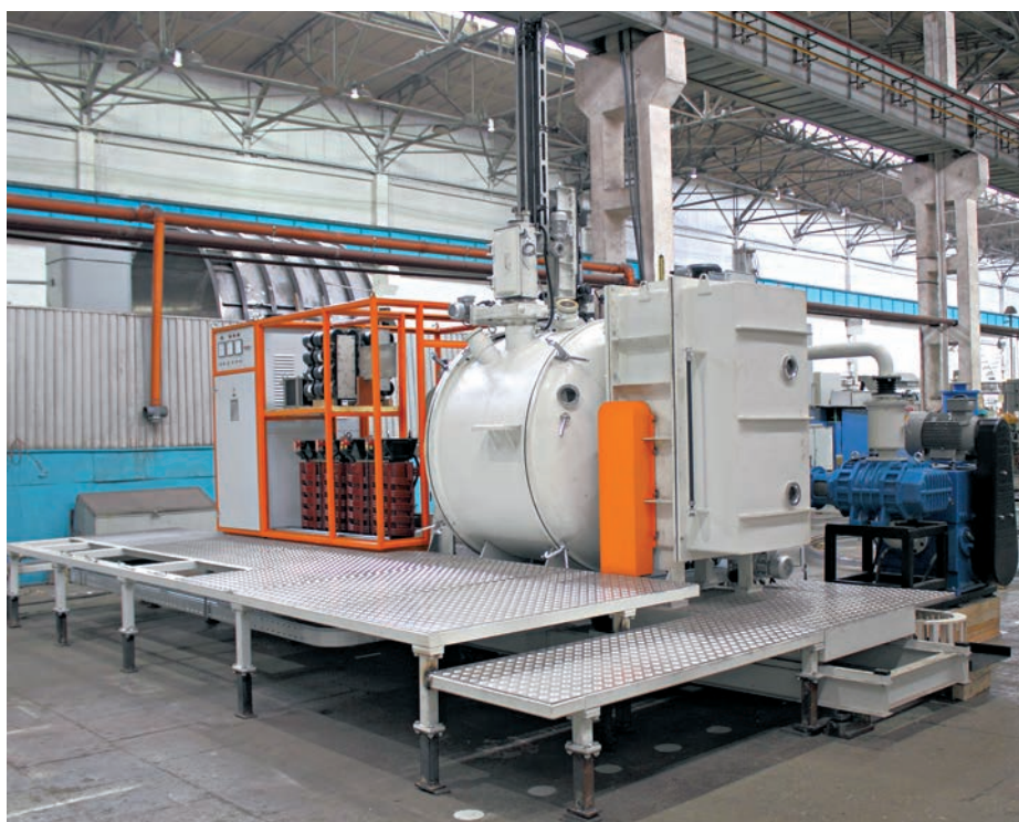
На сборочном участке сварочно-сборочного производства подготовлена к проведению испытаний очередная установка ВИП-НК
