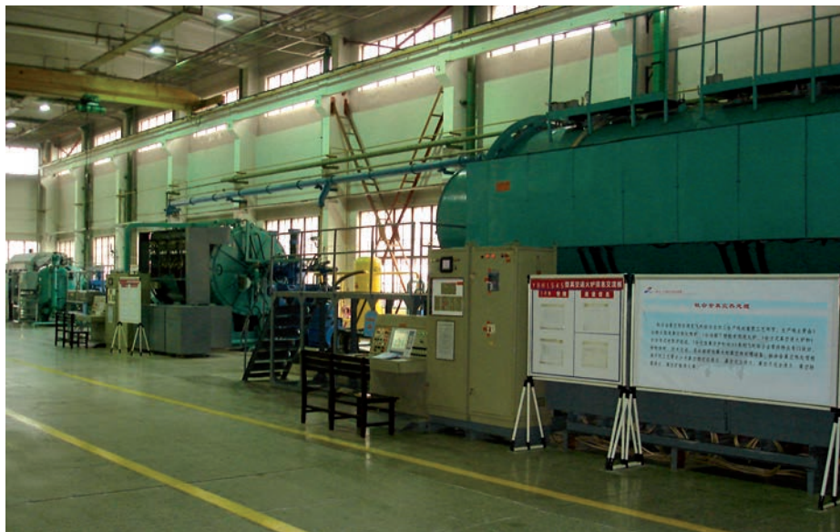
Участок вакуумных термических печей («УВН-1500М», «УВН-1545М», ПВ-850», «СШВ-8»), г. Шеньян, КНР
