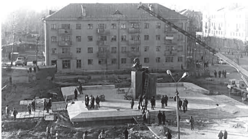
Монтаж памятника на площади Революции в Ржеве. 1987 год
