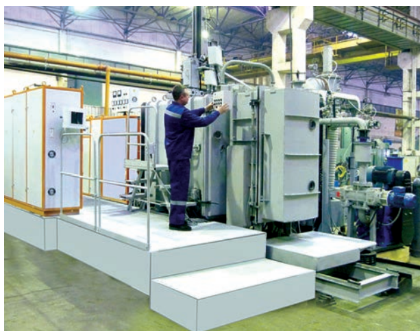
Наладка установки ВИП-НК в сварочно-сборочном производстве
