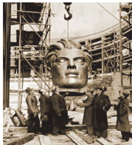
Идет монтаж монумента
